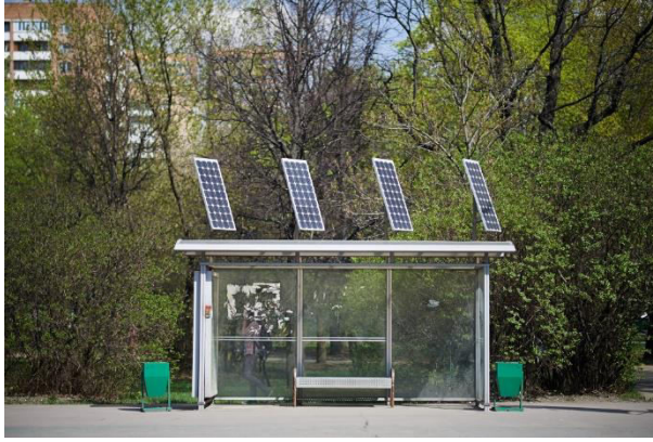
Figura 3. Stație de transport din Moscova pe strada Тимирязевская, 27 [3]
