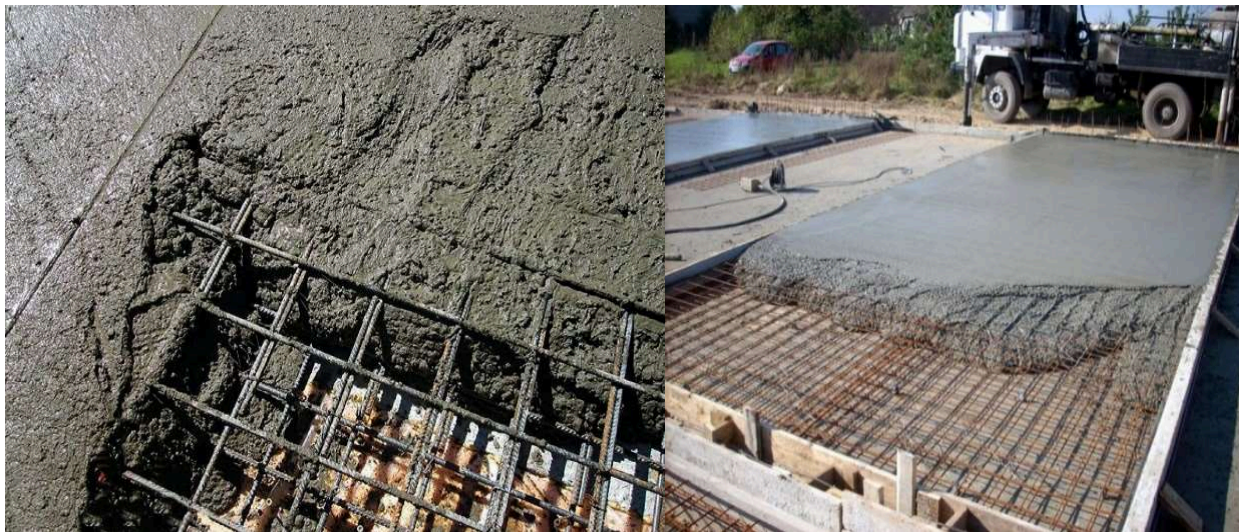
Figura 2. Betonarea unei suprafețe armată cu plase [3]
