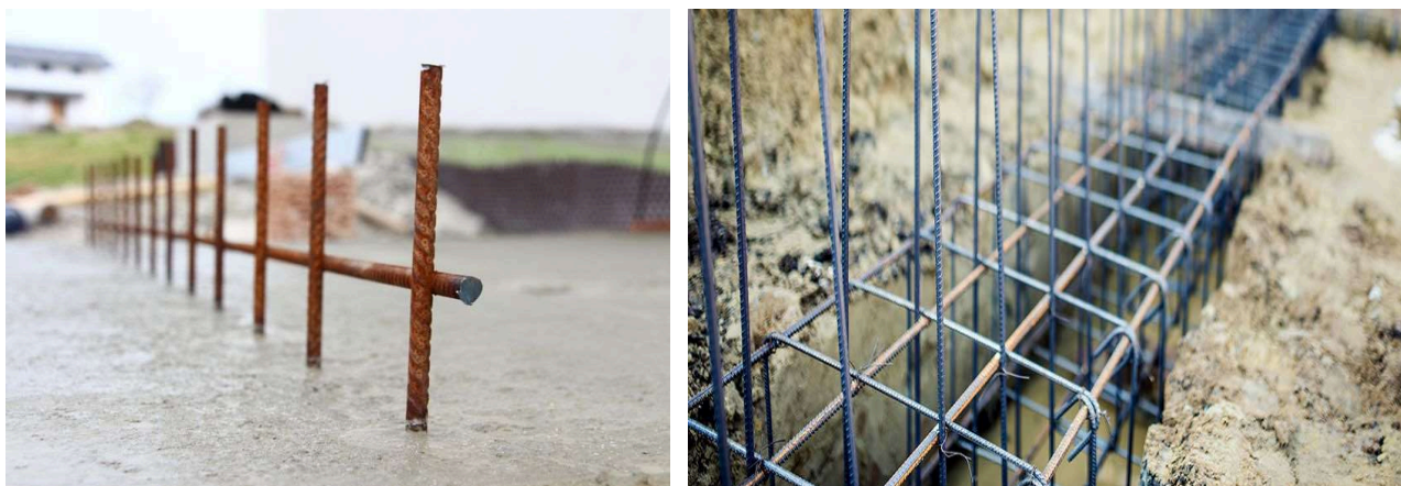
Figura 3. Beton armat cu oțel în cofraje [5, 6]
