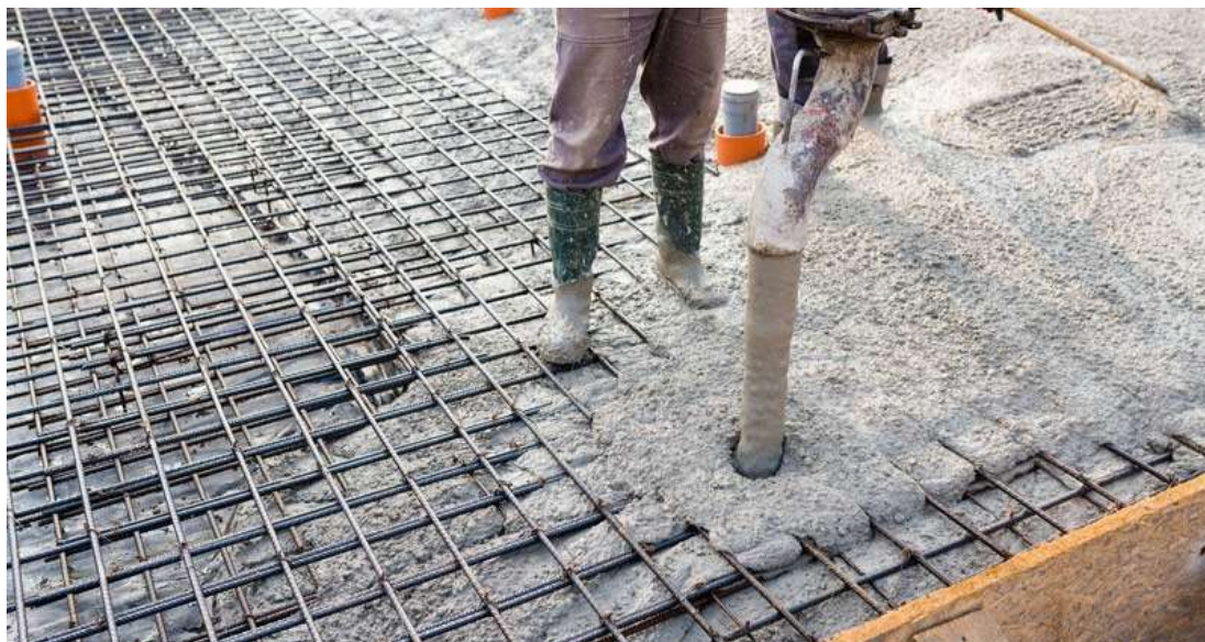
Figura 4. Betonarea cu ajutorul pompei de beton. Beton armat cu plase [6]
